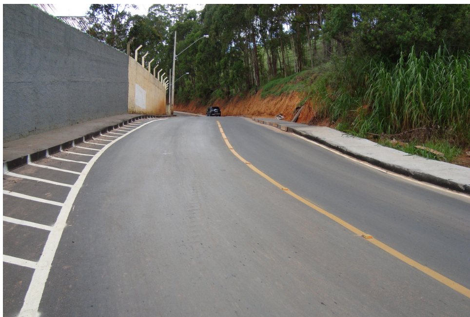
FIGURA 60 – Recente obra de pavimentação asfáltica da via de acesso a Violeira, apesar da grande declividade a mesma não possui rede pluvial
