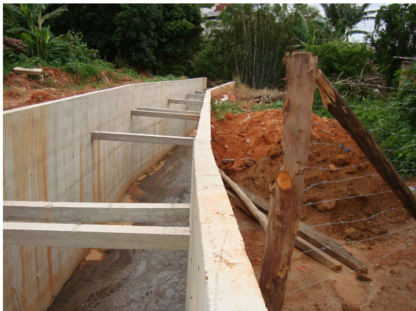
FIGURA 43 - Retificação do córrego Bom Jesus efetuado pelo SAAE/Viçosa
