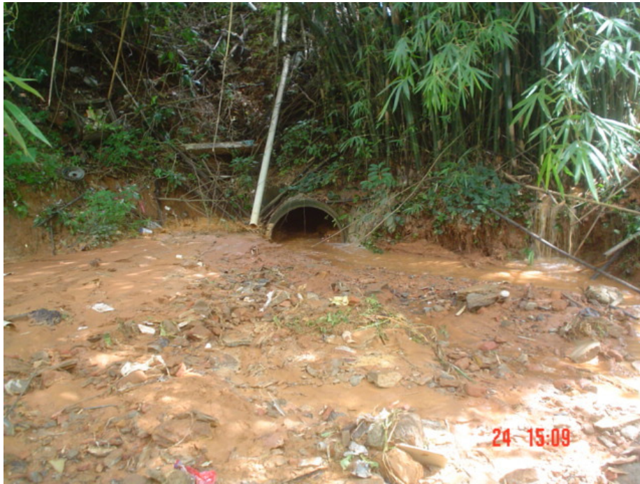
FIGURA 38 – Canalização do córrego Bom Jesus
