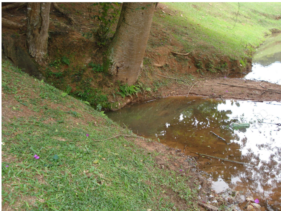
FIGURA 24 – Vista parcial da área assoreada de uma das lagoas da UFV
