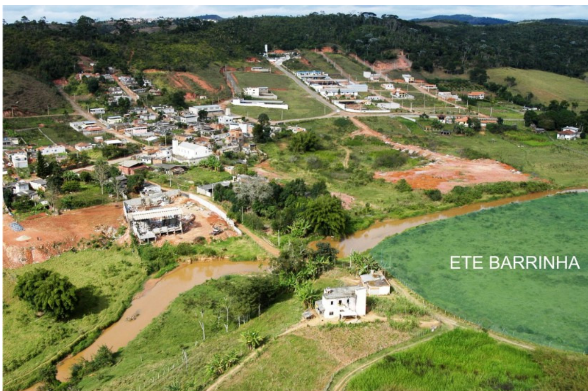
FIGURA 14 – Área destinada para construção da ETE Barrinha
