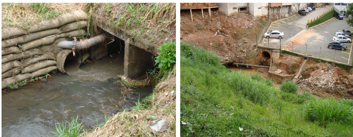
FIGURA 32 –Aspecto visual das galerias que deságuam as águas do córrego da Conceição no ribeirão São Bartolomeu
