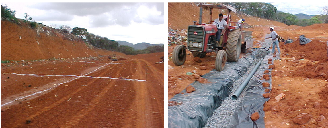
FIGURA 20: Aspecto geral de um talude aberto para receber o lixo (A); abertura impermeabilizado com geomembrana sendo colocado brita e o cano no dreno de drenagem (B)
