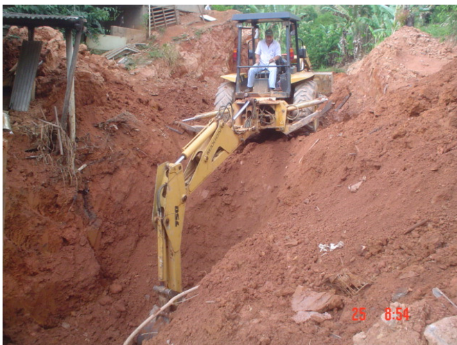
FIGURA 41 – Máquina removendo a terra que obstruiu a canalização do córrego Bom Jesus
