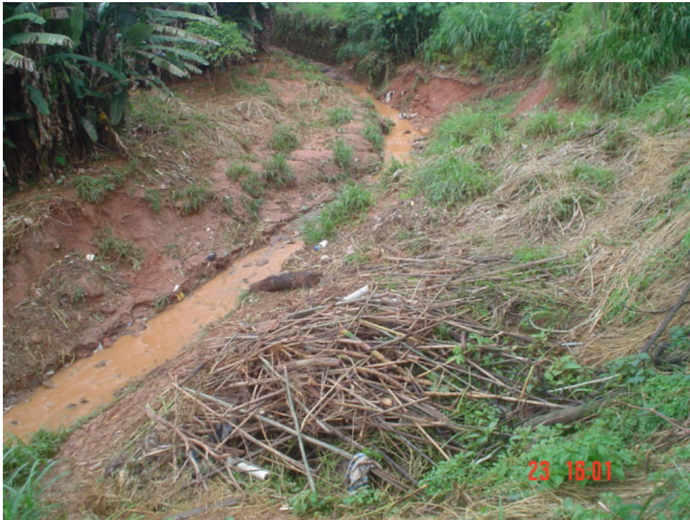
FIGURA 50 – Área de alagamento e acumulação de água localizada a montante da travessa Purdue
