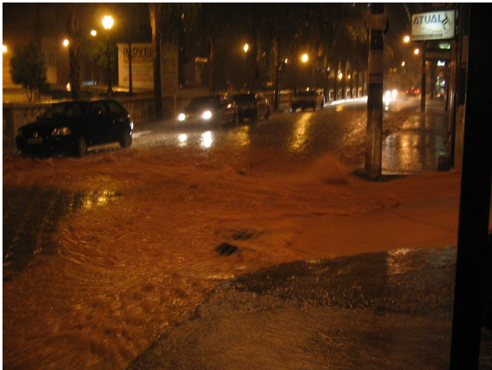
FIGURA 59 – A inexistência de sistema de captação de água pluvial em várias ruas tem causado danos ao pavimento e inundação nas áreas mais baixas de Viçosa, a exemplo do que ocorre em algumas áreas da cidade
