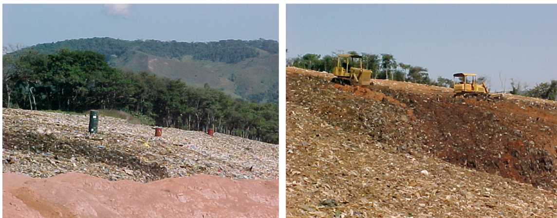
FIGURA 21: (A) Vista parcial do aterro após aterramento do lixo e ao centro da figura os drenos de gás; (B) máquinas fazendo a cobertura do lixo
