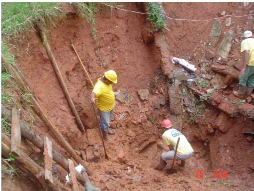
FIGURA 40 – Operários trabalhando na desobstrução da canalização do córrego Bom Jesus
