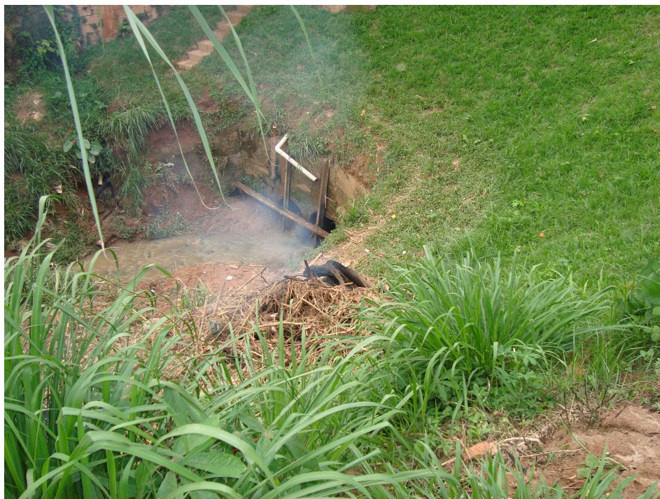
FIGURA 48 – Ponto de estrangulamento do córrego da Conceição (galeria construída com duas manilhas de 1m de diâmetro), na passagem pela Rua Bueno Brandão
