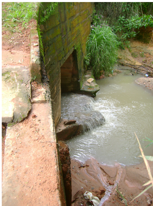
FIGURA 45 – Travessa Santa Luzia (secção quadrada da galeria - 1,5m X 1,5)
