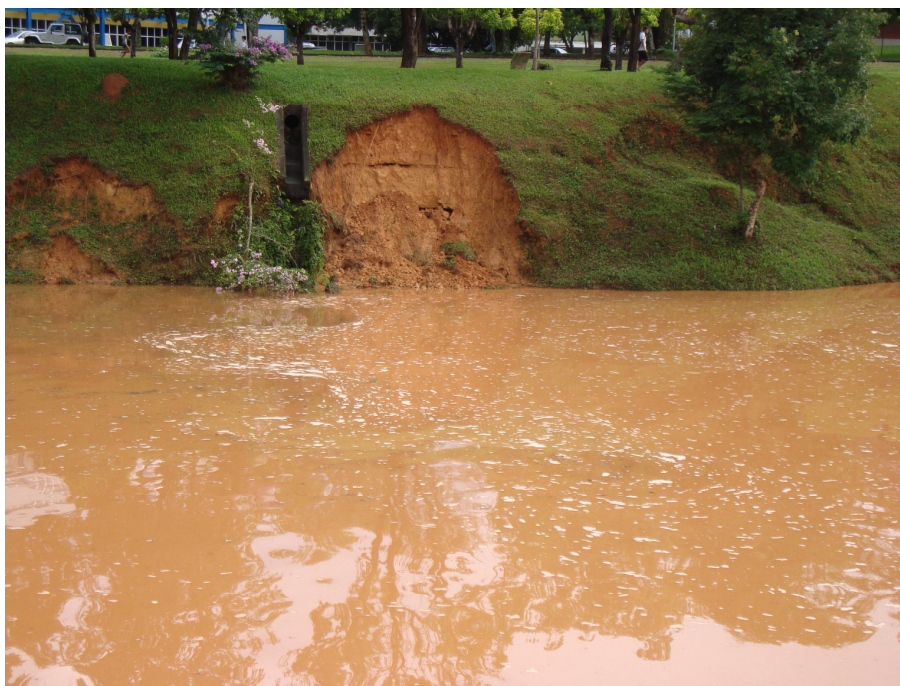
FIGURA 25 – Aspecto visual de erosão ocorrida uma das margem da lagoa da UFV
