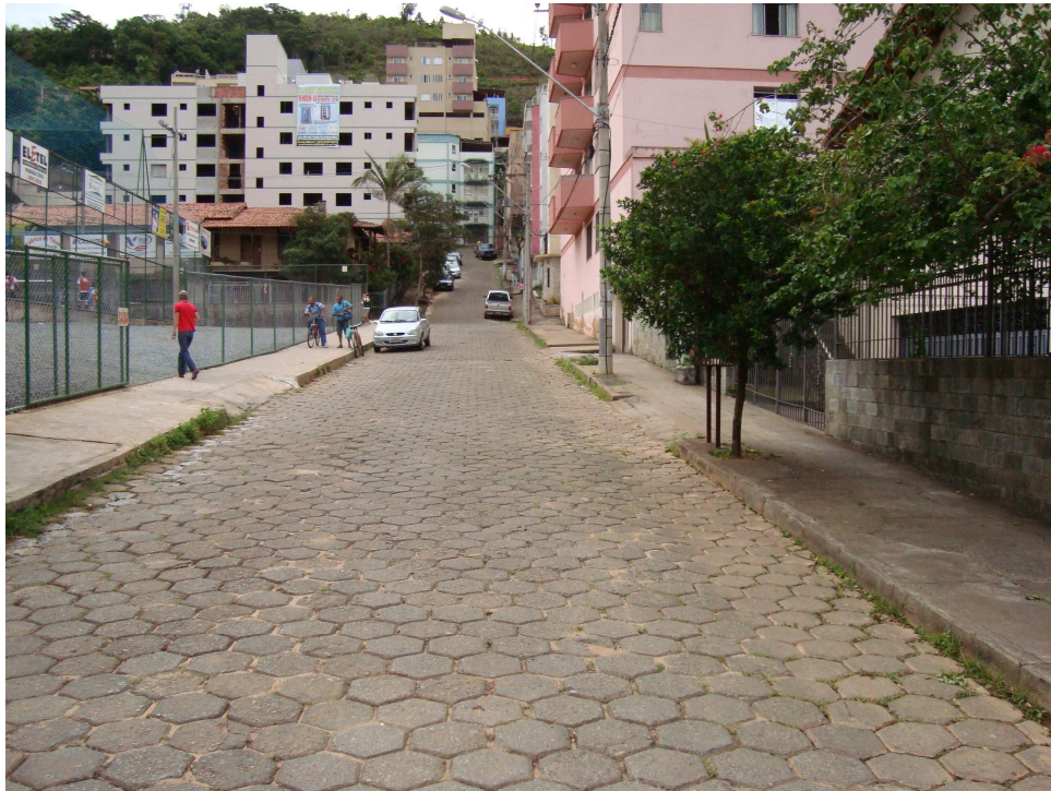
FIGURA 58 – Vista geral de uma rua de Viçosa sem “bocas de lobo”, aspecto similar ao observado em várias ruas que também apresentam a mesma deficiência de sistema de captação de água pluvial
