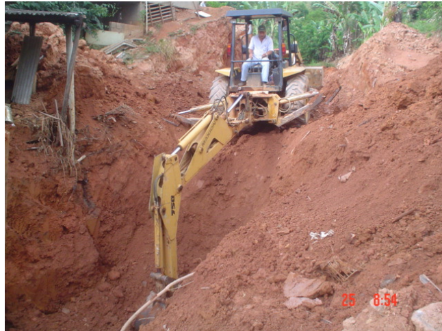
FIGURA 66: Máquina removendo o excesso de recobrimento, o que dificulta muito a manutenção da rede, devido ao custo de escavação
