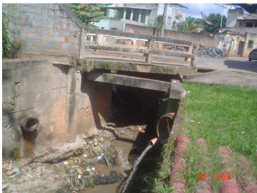
FIGURA 44 - Estrangulamento na ponte do bairro Fátima
