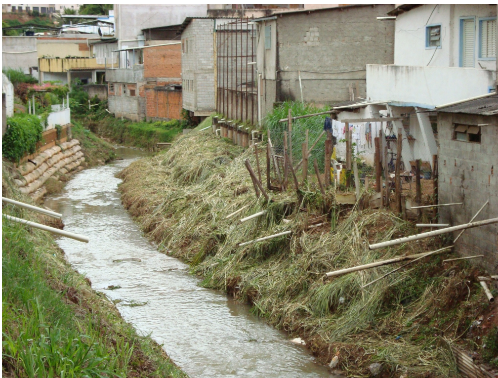
FIGURA 36 – Vista parcial das construções localizadas na Rua dos Passos, chama-se atenção para dois aspectos: proximidade dessas construções do ribeirão São Bartolomeu e os canos para lançamento de esgoto in natura no curso d'água
