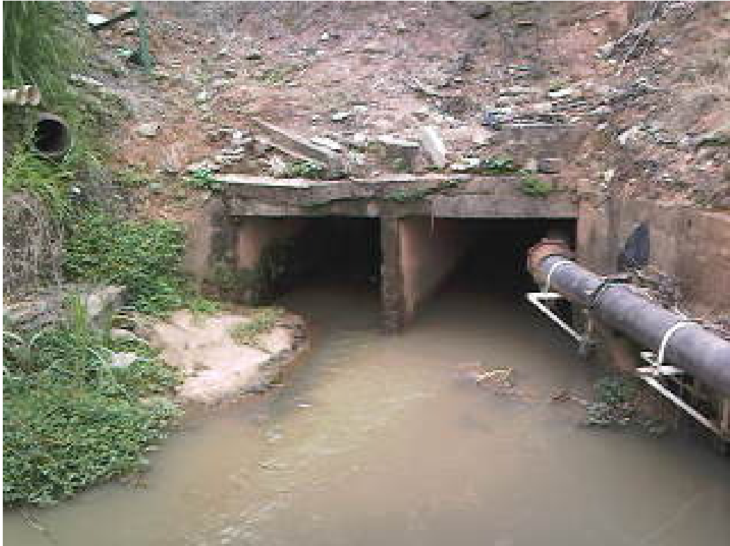
FIGURA 33 – Galeria por onde passa o ribeirão São Bartolomeu construída sob Avenida Castelo Branco
