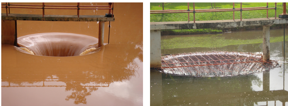
FIGURA 26 – Vista do vertedouro antes (A) e após a instalação da grade de retenção de resíduos (B)
