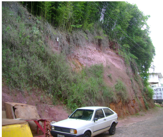
FIGURA 67: Corte inadequado de talude
