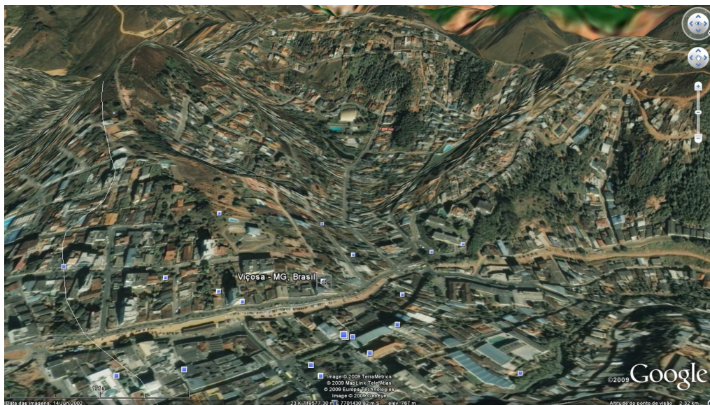
Figura 11 – Vista aérea da área da Bacia – C (Leão, Santa Clara, Lourdes, Betânia e Morro do Cruzeiro), sendo no momento a bacia que apresenta maior índice de inundação
